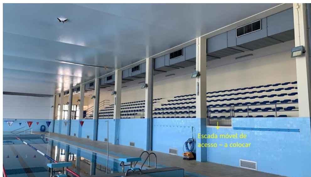
Bancada para atletas e zona de acesso
